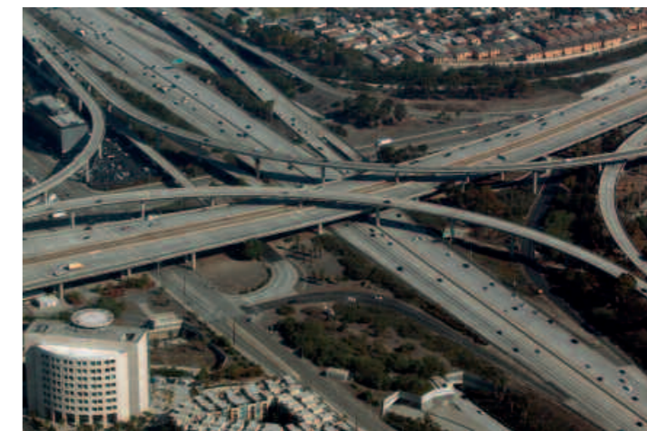
Echangeur routier à Los Angeles.
